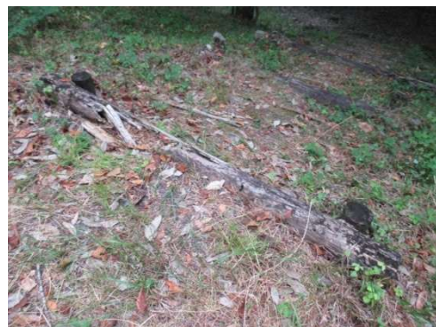
⑪木製階段の劣化
